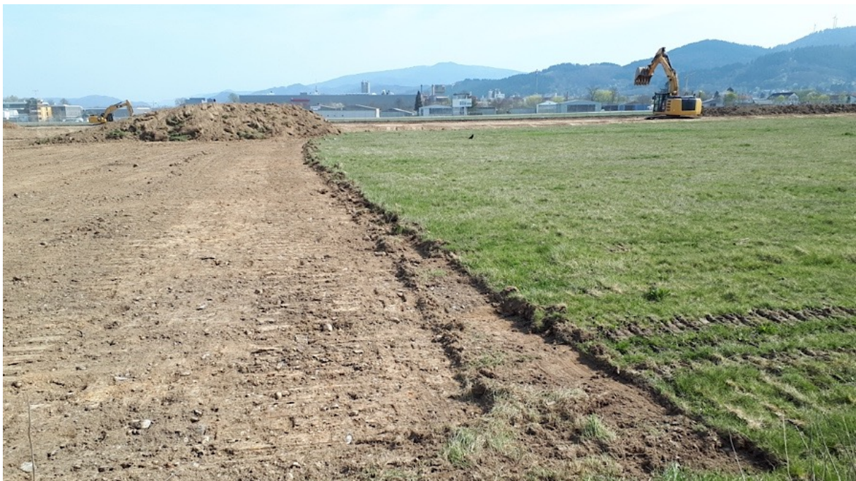
Abbildung 1: Entfernung des Oberbodens auf der Stadion-Baustelle. Hierbei wurden die obersten Zentimeter des Magerrasens mit Baggern abgezogen. Foto: Anna Paulina Schmid.
