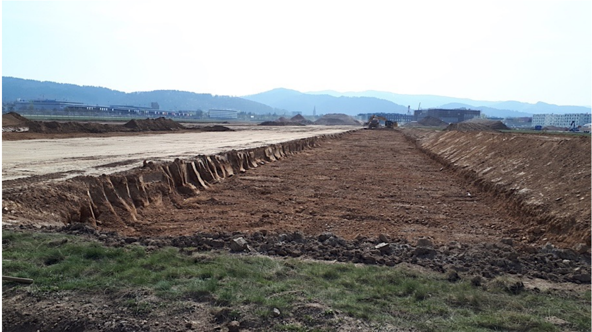
Abbildung 2: Entfernung des Unterbodens auf der Stadion-Baustelle. Hierbei wurde der Boden des Magerrasens zwischen 15 und 70 cm Tiefen abgegraben. Foto: Anna Paulina Schmid.
